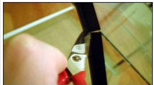
Las cantoneras se pueden cortar con unas tijeras fácilmente.
